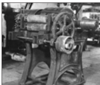
Màquina circular talladora de draps
